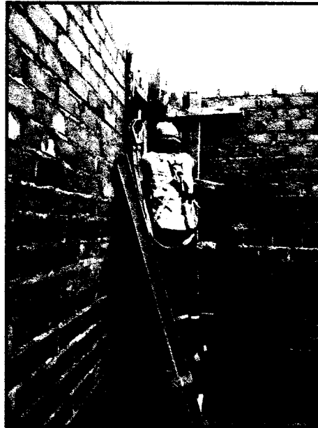
Uso de arnés de seguridad
