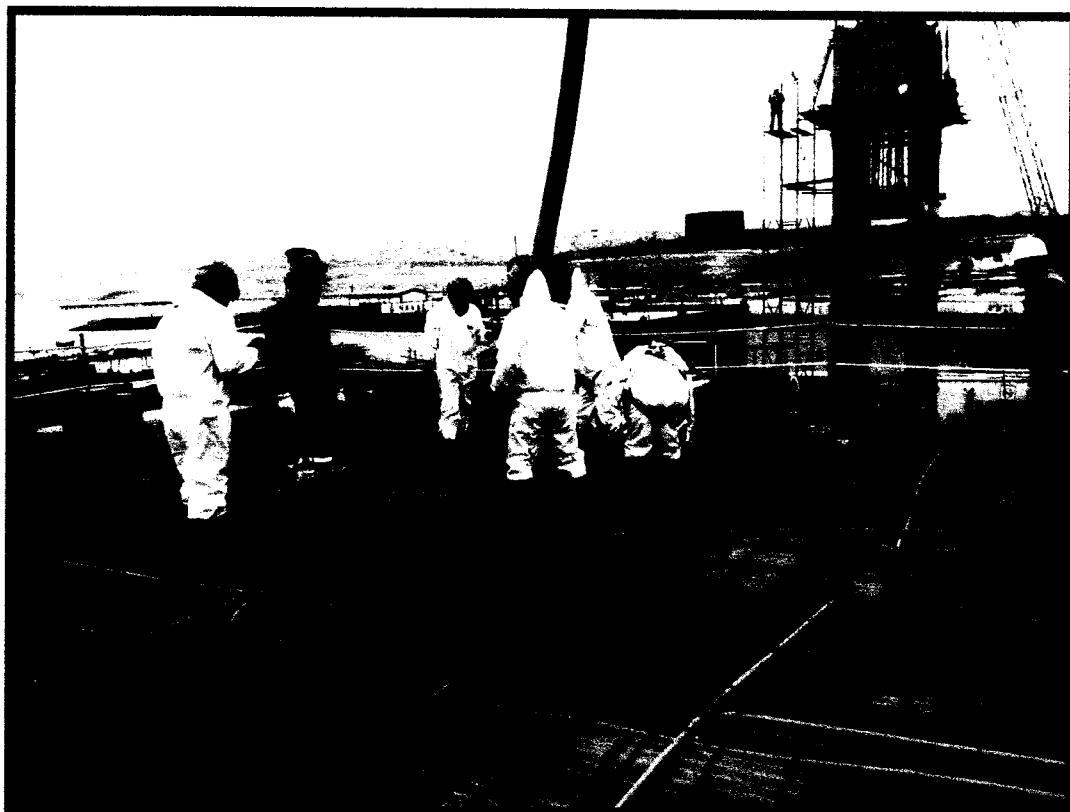
Partida 05.04.18: LOSA ALIGERADA, CONCRETO f'c=210 kg/cm 2 .
